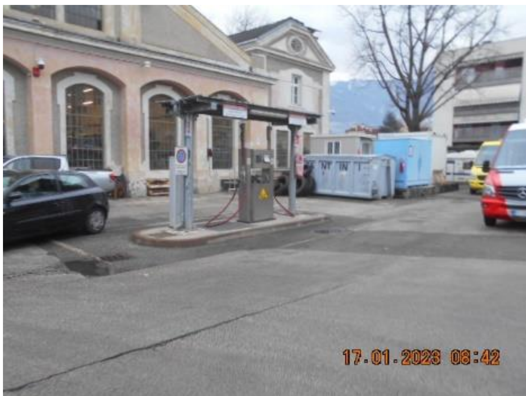
9 - Erogatore carburante (metano) sul lato sud da rimuovere
