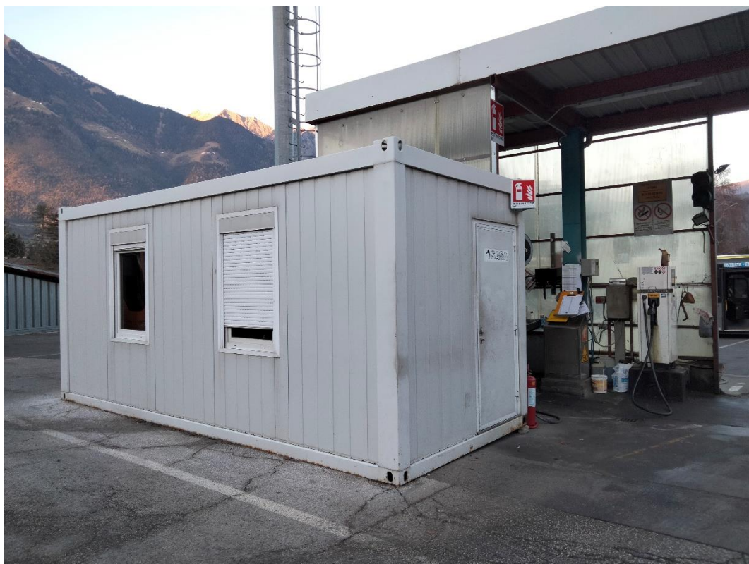
15 - Erogatore carburante (diesel) sul lato nord da rimuovere
