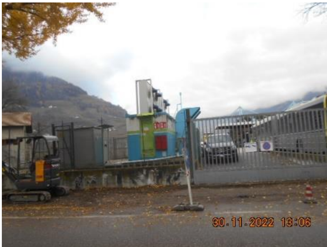
3 - Zona di intervento (rimozione impianti: a cura di SASA, demolizione basamenti e muretti, rimozione recinzioni: a cura appaltatore)
