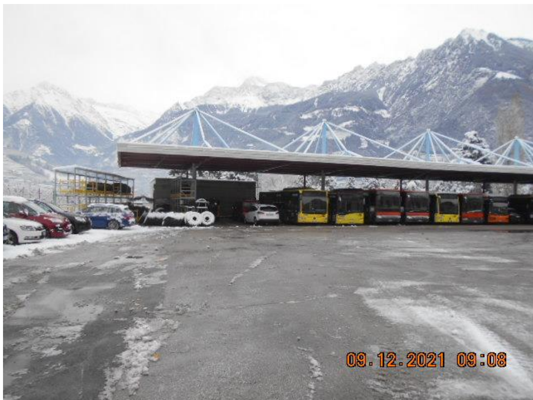
31 - Area di intervento (n. 3 campate da 6,90 m/ciascuna della tettoia lato sud da rimuovere per interferenza con carro bombolaio)
